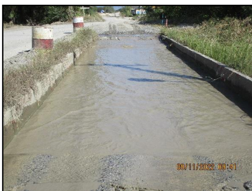
ภาพที่ 3.57 บ่อล้างล้อรถบรรทุกในช่วงถนนคอนกรีตของเส้นทางขนส่งแร่
