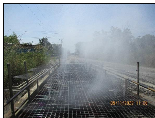
ภาพที่ 3.57 บ่อล้างล้อรถบรรทุกในช่วงถนนคอนกรีตของเส้นทางขนส่งแร่
